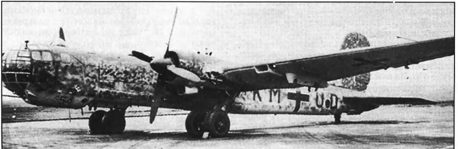
Тяжелый бомбардировщик Хейнкель He 177 отличался установкой спаренных двигателей
